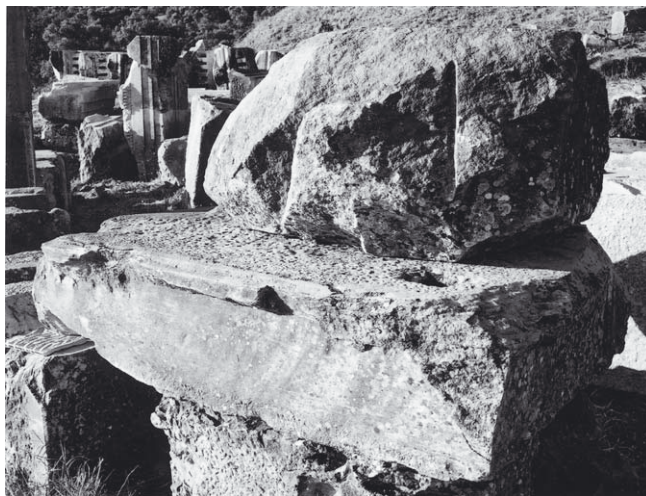
Abb. 91: Architekturprobe Südostecke mit dorischem Eckarchitrav B06/1706 und Ecktriglyphenblock B06/1707 mit vertikalem Gusskanal zu innenliegendem Dübel
