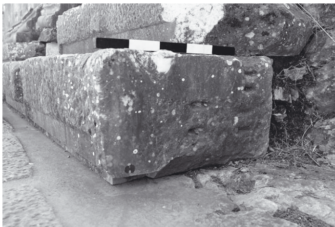
Abb. 9: Krepisstufe der Ostseite mit seitlichen Stemmlochreihen
