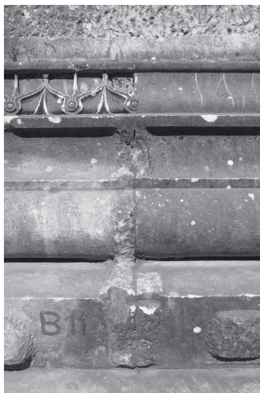
Abb. 12: Sockelprofil der Westseite, Übergang vom ausgearbeiteten zum nicht ausgearbeiteten Kyma an der linken Stoßkante des Mittelblocks
