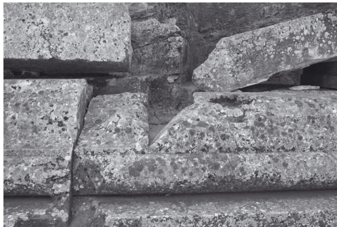
Abb. 24: Linker Sockelprofilblock mit Übergang zur Scheintürschwelle der Nordseite, mit Gehrugsausnehmung für den Gewändeblock
