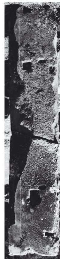
Abb. 15: B00/45+47, O Doppelblock der Schicht 6 von der Ostseite mit Kantendübelöchern
