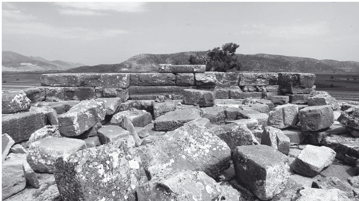
Abb. 62: Innenansicht der nördlichen Hofwand
