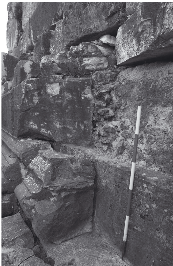
Abb. 20: Mörtelpackung mit Bruchsteinen hinter 6W24 aus Schicht 6 der Westseite
