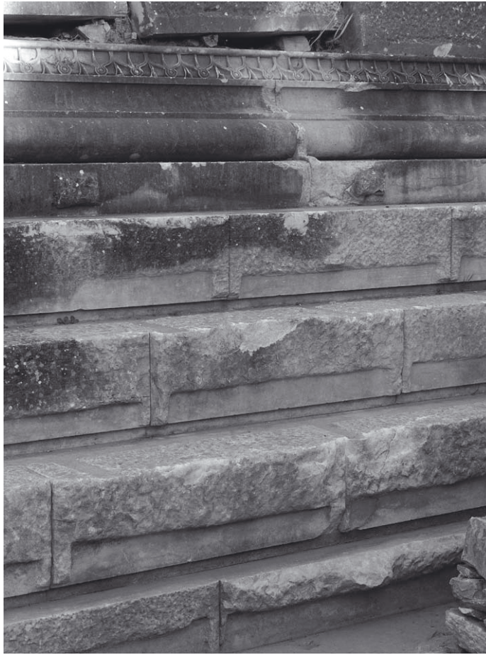
Abb. 10: Krepis und Sockelprofil an der Westseite
