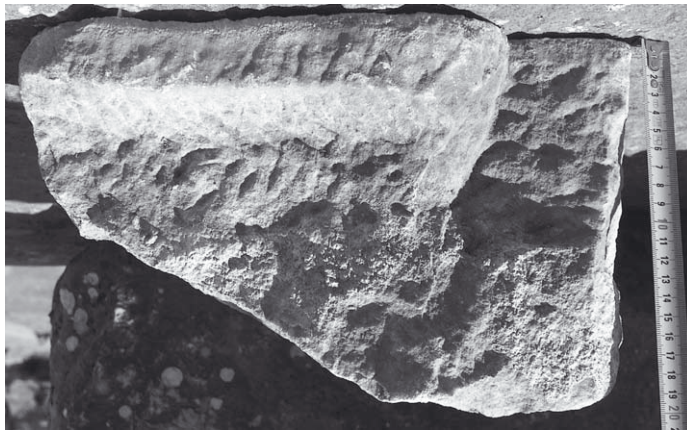
Abb. 58: B01/465, U Fragment einer Überlappungsnase einer Dachplatte mit ausgeklinkter Unterkante
