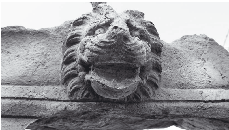
Abb. 47: Löwenkopf ohne Wasserspeierfunktion auf dem Peristasisgesimsblock B03/1570
