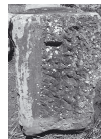
Abb. 16: B00/45+47, R Doppelblock der Schicht 6 von der Ostseite mit seitlichen Stemmlöchern
